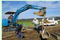
コンクリート水路の更新
