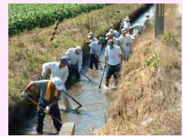
水路の泥上げ
