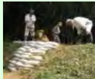
漏水箇所の補修
