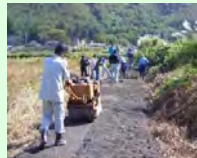
未舗装農道の舗装
