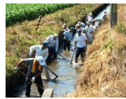
水路の泥上げ
