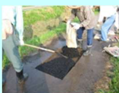
農道の部分補修
