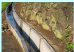
素掘り水路からコンクリート水路への更新
