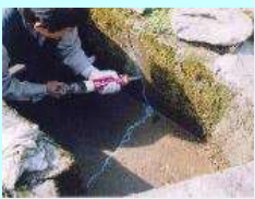
水路のひび割れ補修
