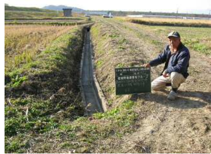
土側溝をコンクリート側溝に更新
