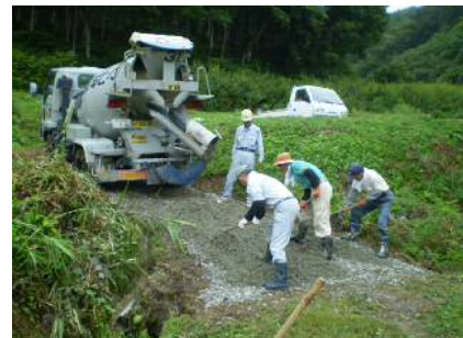
コンクリート舗装状況
