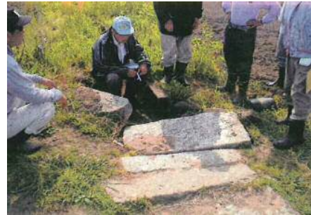
側溝蓋の損傷
