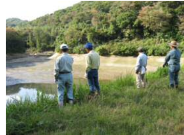
フェンスなどの安全施設がないため池
