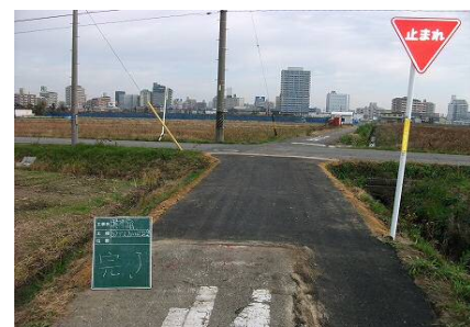
アスファルト舗装の打換え
